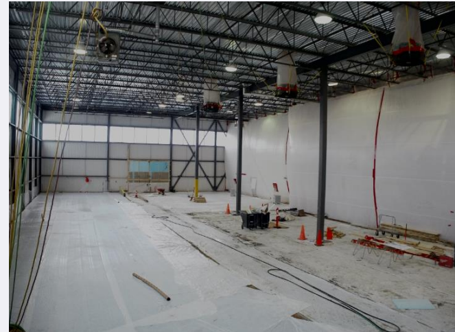
Investissements à l'usine de Boisbriand
